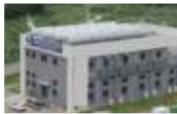
国内首个全直流数据中心(东莞安华) ——固态变压器
